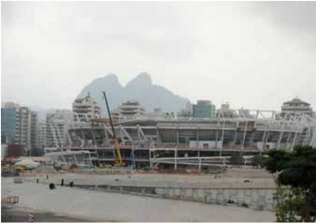
Obras no Parque Olímpico, na região da Barra da Tijuca Foto: Tânia Rêgo/Agência Brasil
