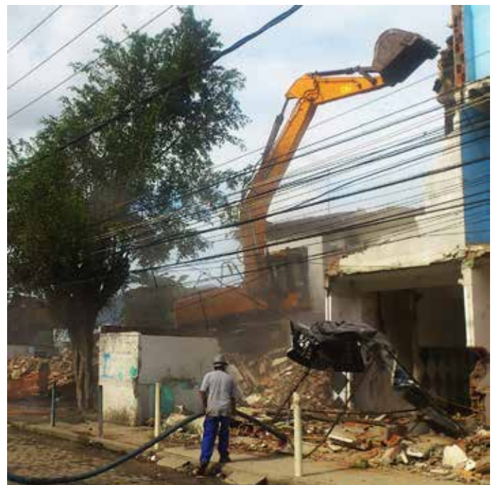
Derrubada de casa em pleno domingo na Vila União de Curicica Foto: Thiago Mendes/Comunicação Pacs (17/05/2015)
