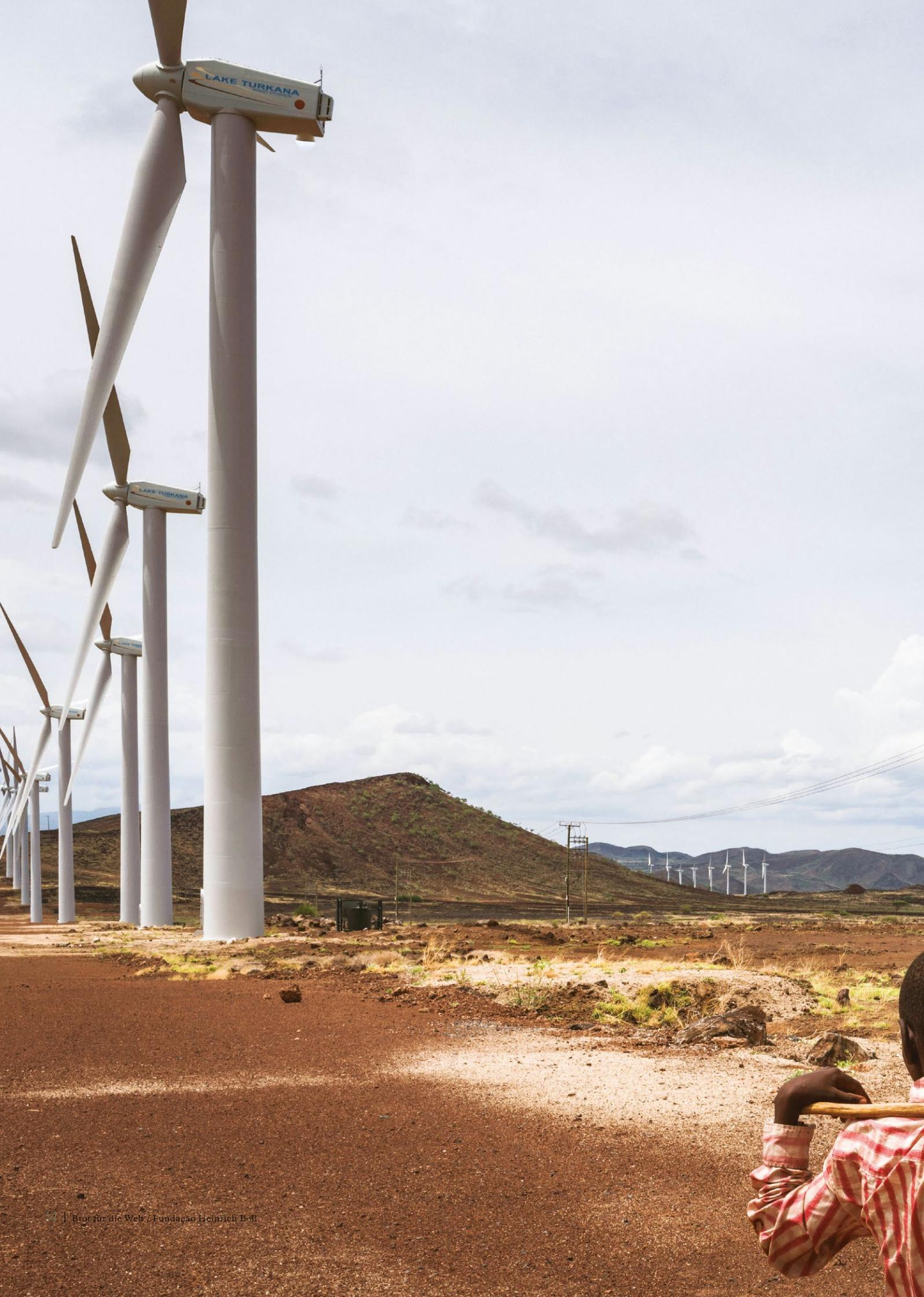
Condado de Marsabit, Quênia: As estruturas permanentes da Lake Turkana Wind Power (LTWP) incluem 365 turbinas eólicas, uma subestação e acomodações para trabalhadores. As turbinas foram instaladas uma por dia ao longo de um ano. Cada uma tem uma capacidade de 850 quilowatts. Elas fornecem 310 MW de energia para a rede nacional do Quênia. © Maurizio Di Pietro / Climate Visuals Countdown
