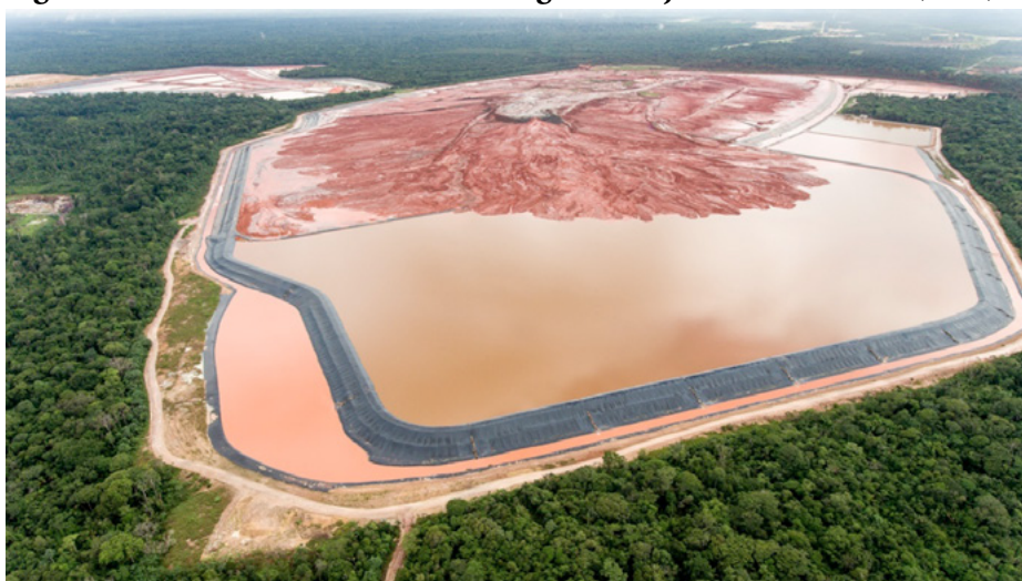
Figura 2 – Vazamento de sílica de barragem de rejeitos – Barcarena (2018)
