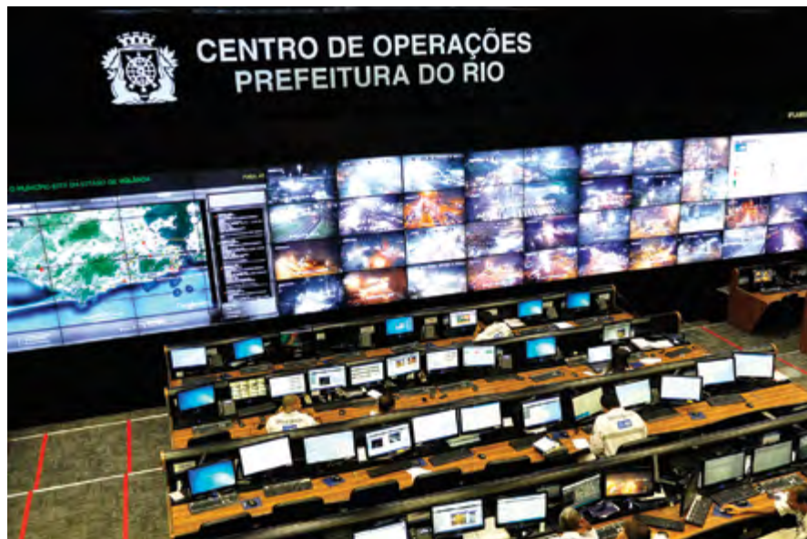
Centro de Operações Rio, 2013.
